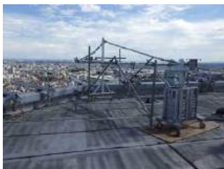
屋上の突りょう（ゴンドラを安全に吊り下げるためのアーム）
