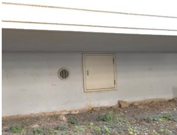
クラックおよび点検口 下部の発錆
