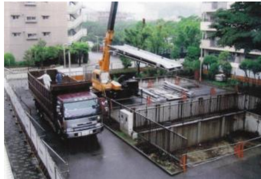
機械設備撤去
