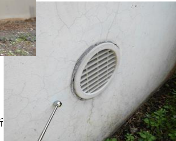
クラックおよび点検口 下部の発錆
