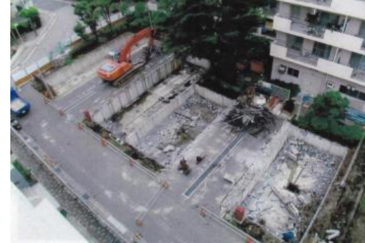
地下ピット解体撤去
